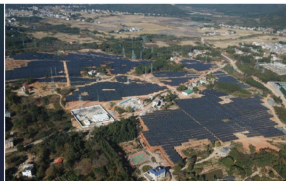
广东东源 100MW 光伏电站项目并网
