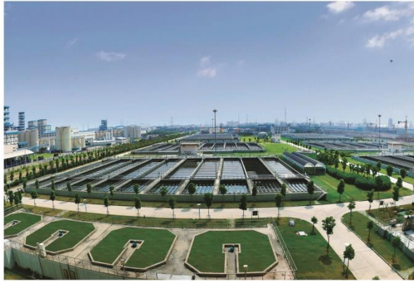
上海白龙港污水处理厂
