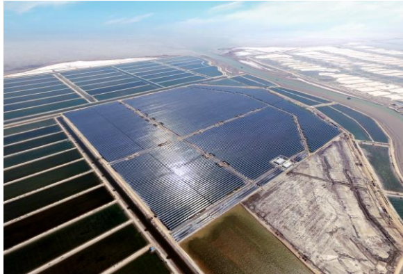
山东曙光光伏项目
