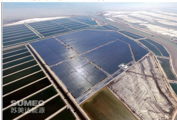
山东曙光光伏项目
