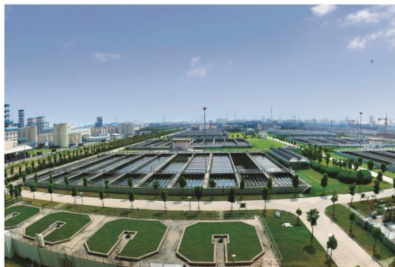
上海白龙港污水处理厂
