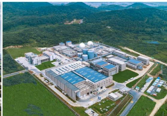
南京江北废弃物综合处置中心
