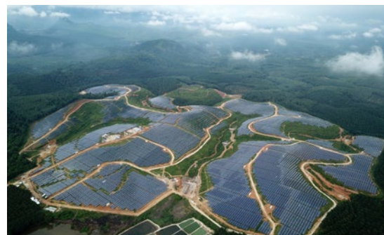
马来西亚 62MWp 光伏电站项目
